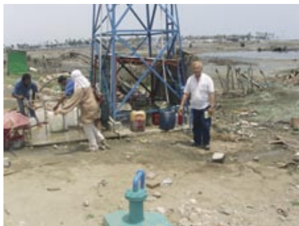
Nieuw geboorde waterput
